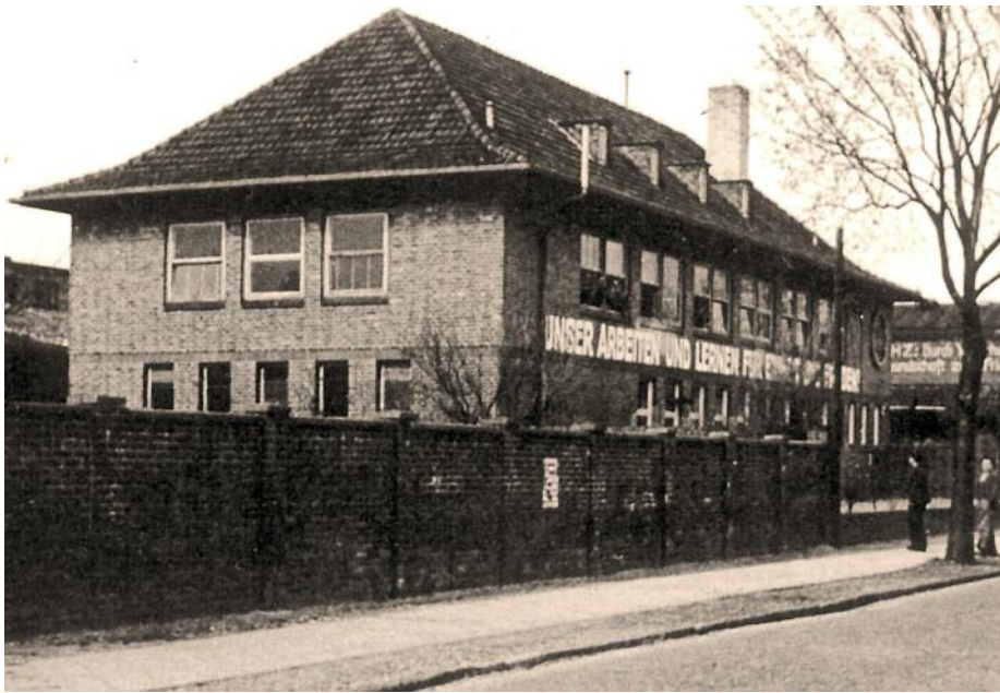
Das ehemalige Gefolgschaftshaus der HIAG als erstes eigenes Schulgebäude (später Haus 2) sowie große Teile des ehemaligen DEGUSSA-Betriebsgeländes wurden der Fachschule im Sommer 1950 zur ständigen Nutzung übergeben.
